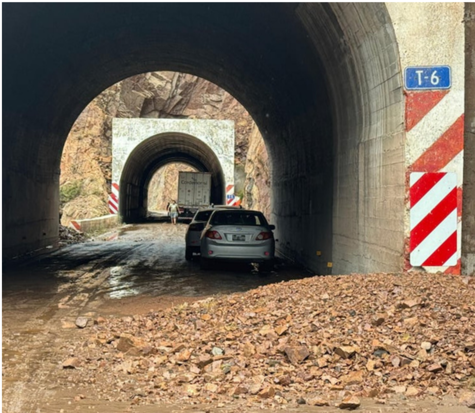
Dos aludes de tierra, agua y piedras interrumpieron la ruta internacional que conecta Chile con Argentina, dejando la carretera completamente inhabilitada.
